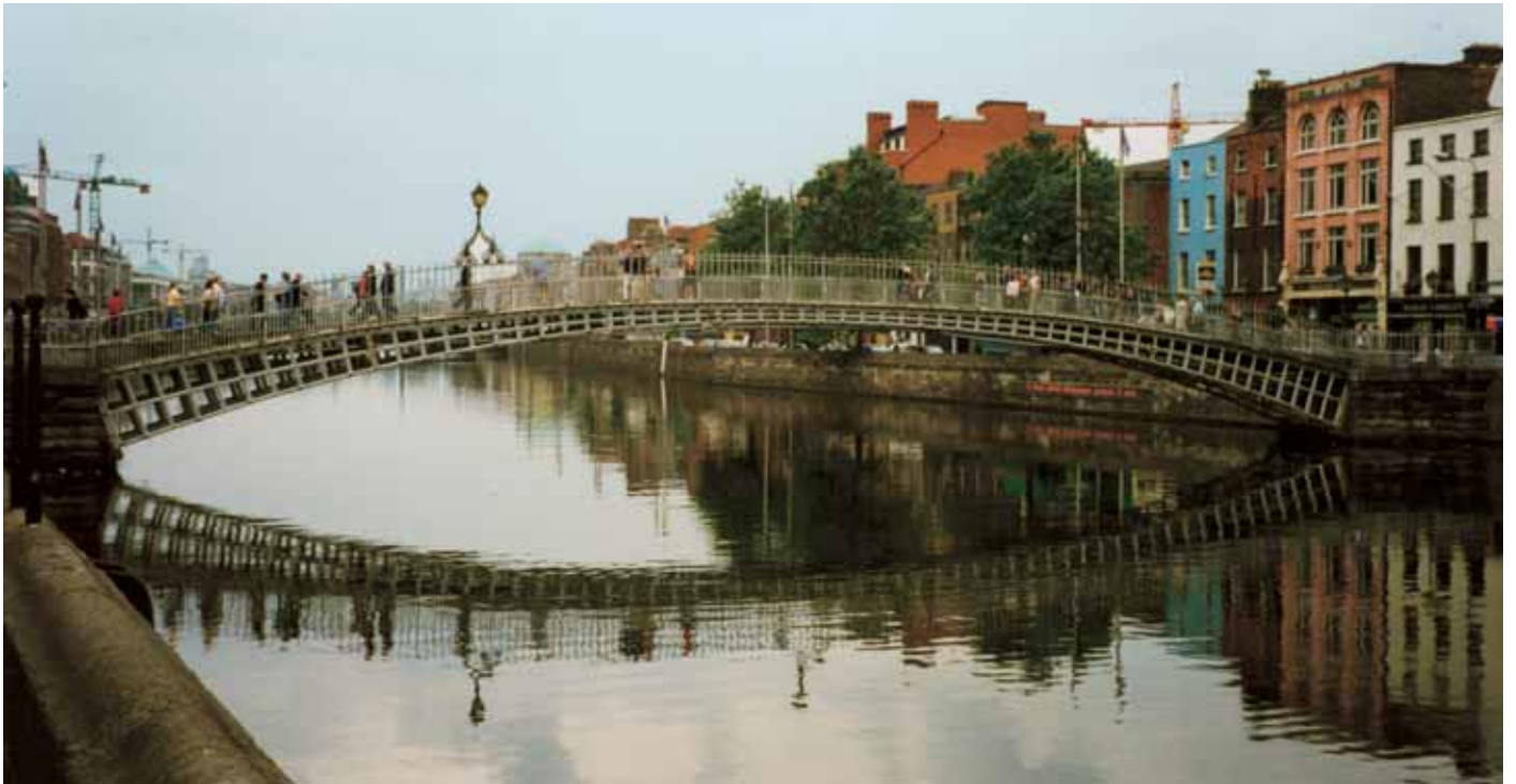
Auf der Half Penny Bridge in Dublin muss heute kein Wegezoll mehr bezahlt werden
